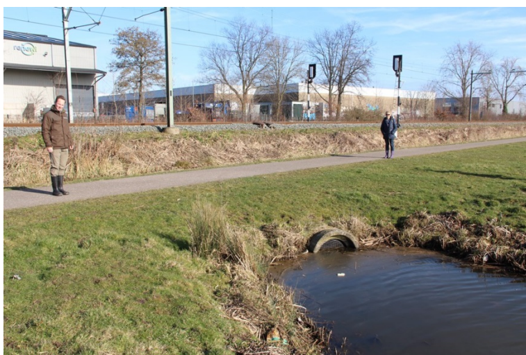
Figuur 6. Jasper Ohm van Zuid-Hollands Landschap (links) en Jet de Lange van Gemeente Zoeterwoude (rechts) geven het 10 meter lange gedeelte van het fietspad aan dat verhoogd gaat worden ten behoeve van de aanleg van nieuwe duikers. Verhoging van dit gedeelte is een kans om meer nestelgelegenheid voor bodemnestelende bijen in het terrein te brengen. Met een verhoging van anderhalve meter met schraal leemhoudend zand kan aan de zuidzijde van dit pad een zeer goede nestelwand ontstaan.
